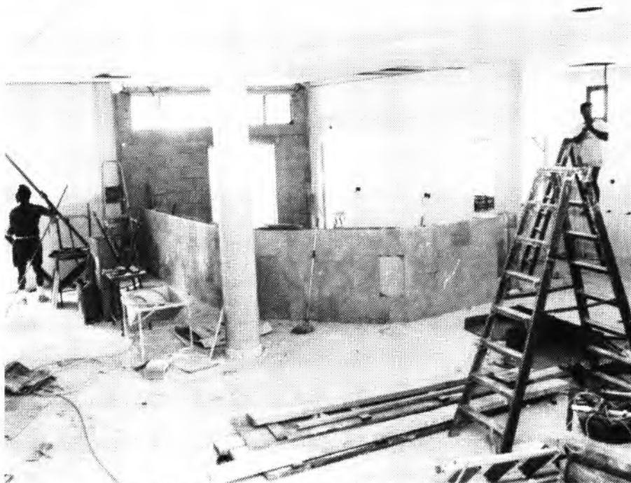
De moment manca instal·lar el mobiliari i arreglar els darrers detalls.
