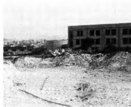
Les màquines han treballat durant quatre mesos amb la perforació del terreny
