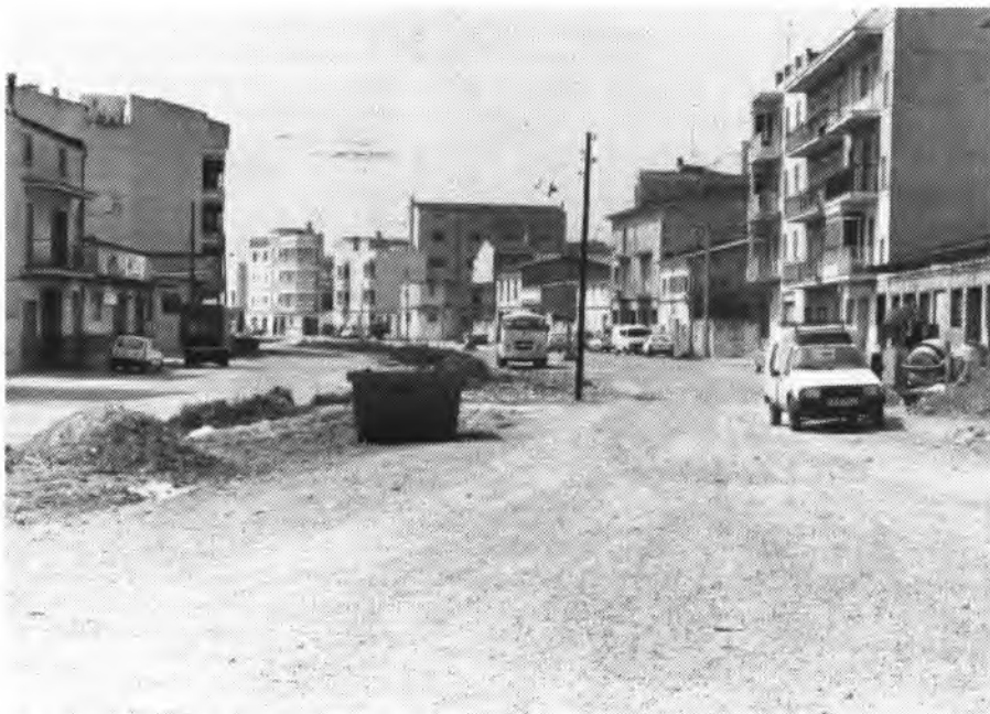
La subvenció del Govern Balear es destinarà a les obres de la calçada mentre l'Ajuntament es farà càrrec de les voraries, zones ajardinades i adornaments en general.
