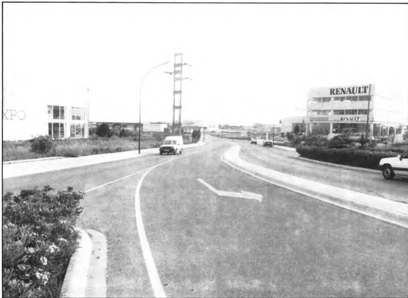
El Polígono Industrial de Manacor cuenta con un fácil acceso así como una perfecta infraestructura.
