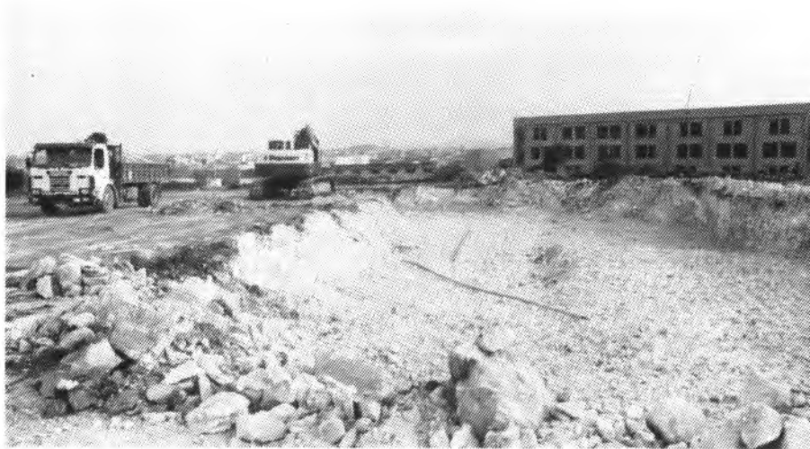
El alcalde de Manacor, visita casi a diario, los terrenos en donde se construirá el Hospital Comarcal
