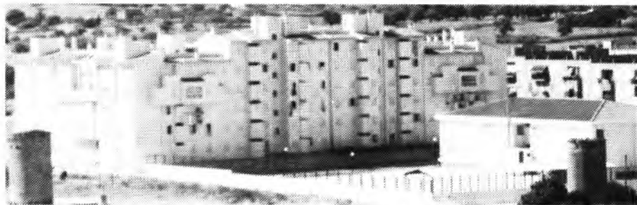
El complejo residencial de protección oficial de Es Serralt consta de 100 viviendas.
