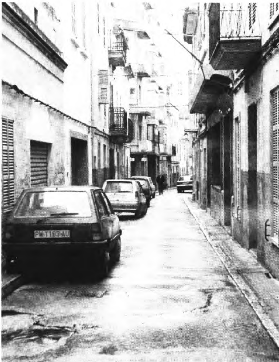
També al carrer de l'Estrella és un dels més afectats, com molts d'altres del centre
