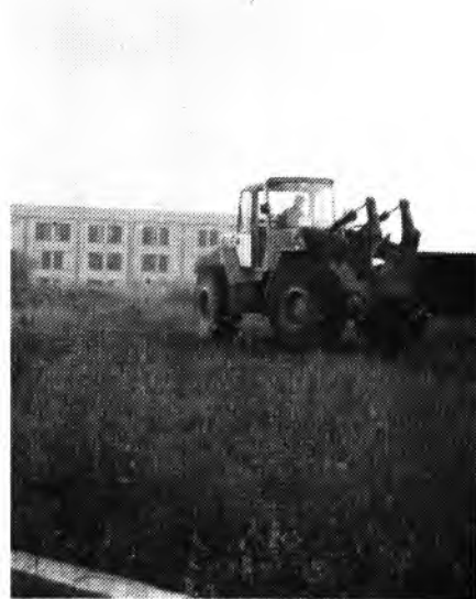
Una excavadora de l'empresa «Dragados y Construcciones» començà ahir, damunt les nou i mitja del dematí, a aplanar el terreny on es construirà l'hospital.
