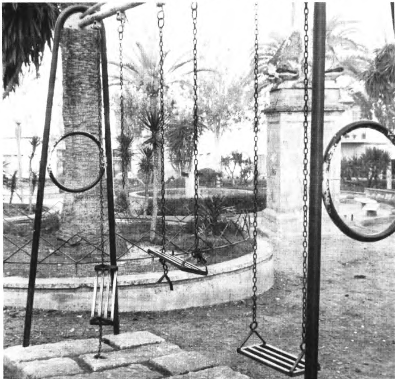
Les engronsadores de la pl. Sant Jaume, en molt mal estat.
