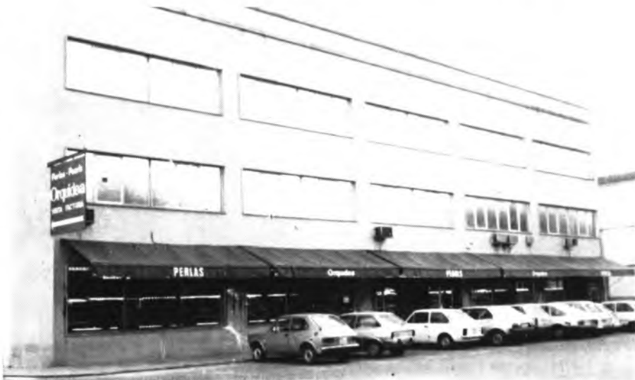
A principios de 1993 la fábrica de perlas se trasladará a Montuïri, dado que dentro de unos meses, se iniciarán las obras de construcción de la nueva nave.
