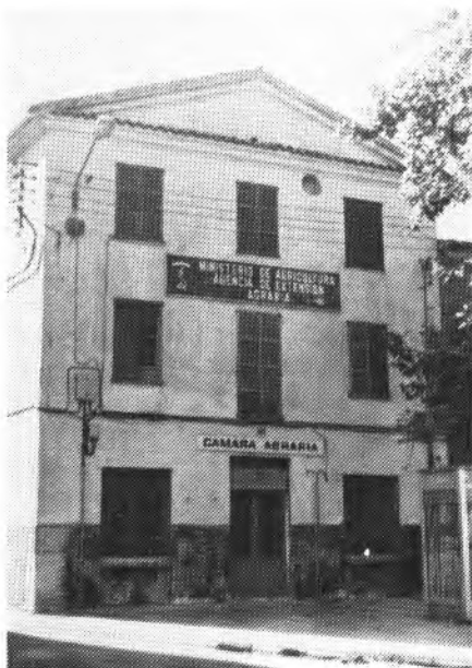
El Centre Cultural es construirà als terrenys que ocupa la Càmera Agrària.
