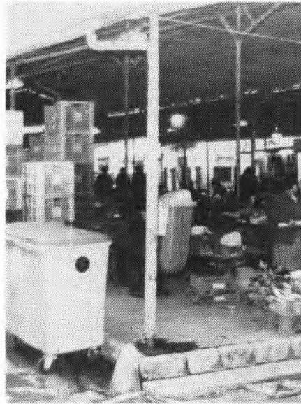
El nou projecte de reforma de la plaça de Ses Verdures permetrà que els majoristes puguin continuar allà la seva activitat.
