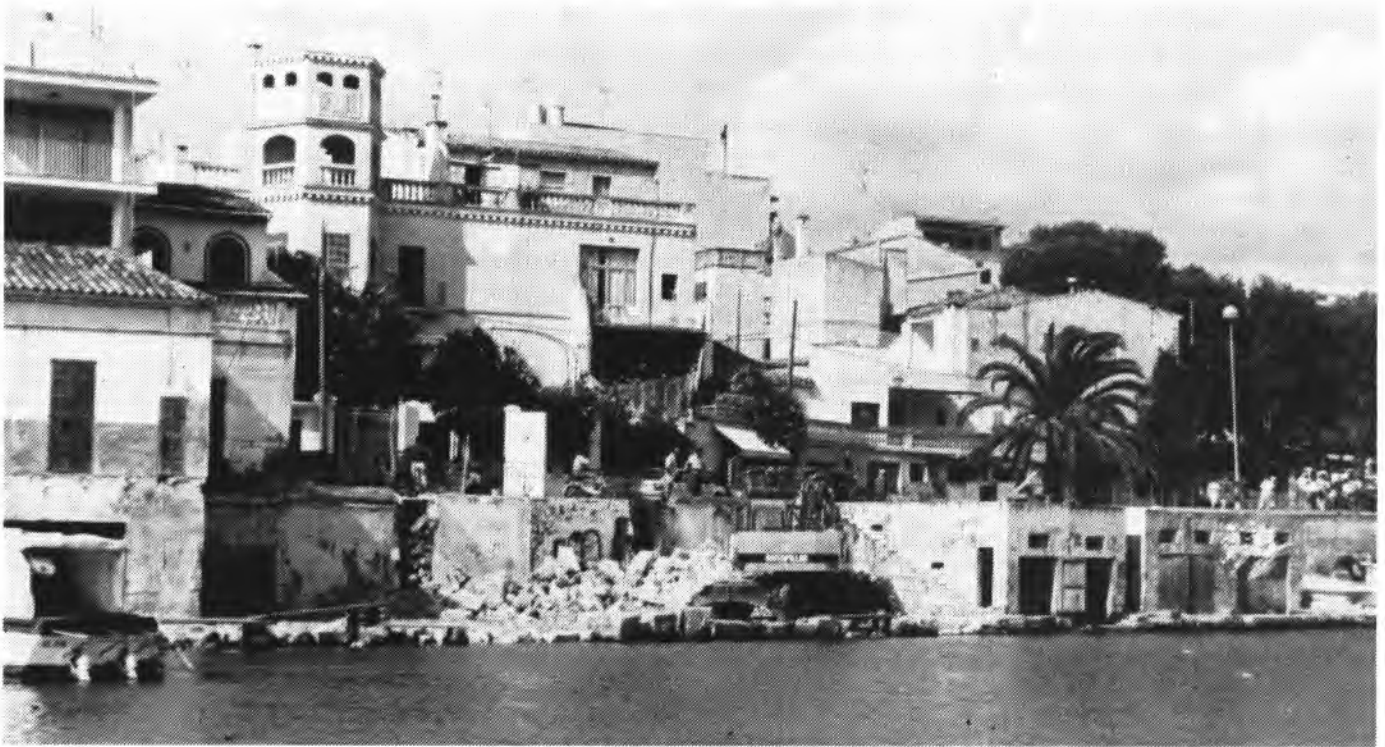
Fa un parell de setmanes començaren les obres d'enderrocament dels antics escars.
