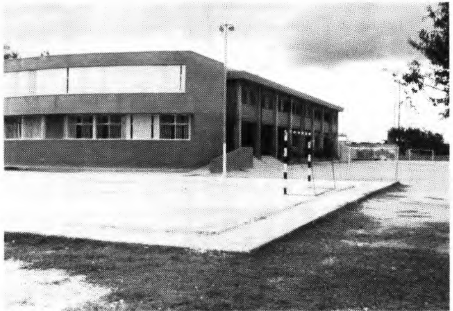
A la zona del pati del Col.légi Mitjà de Mar es construiran quatre noves aules.
