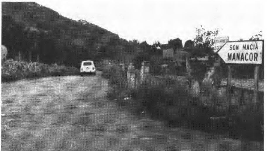
L'asfalt de la carretera de Son Macià-Cales de Mallorca, es troba en aquets moments intransitable.
