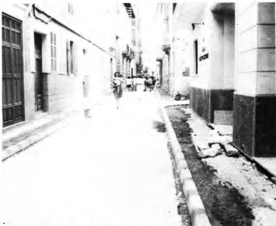
Els carrers després de la reforma caracteritzat per l'estretor.
