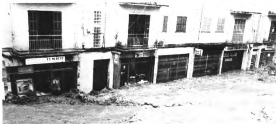
Malgrat les obres d'eixemplament i encimentació del cau del torrent, segueix essent massa estret en el seu pas per dins la ciutat.
