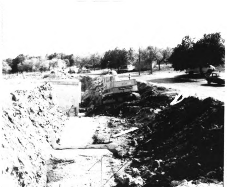
En estos momentos las obras van por buen camino
