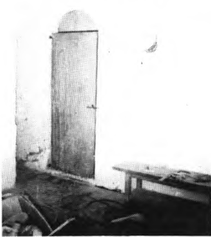
Por la obertura que queda encima de la puerta entraron los supuestos ladrones en los vestuarios para hacerse con el material de construcción.
