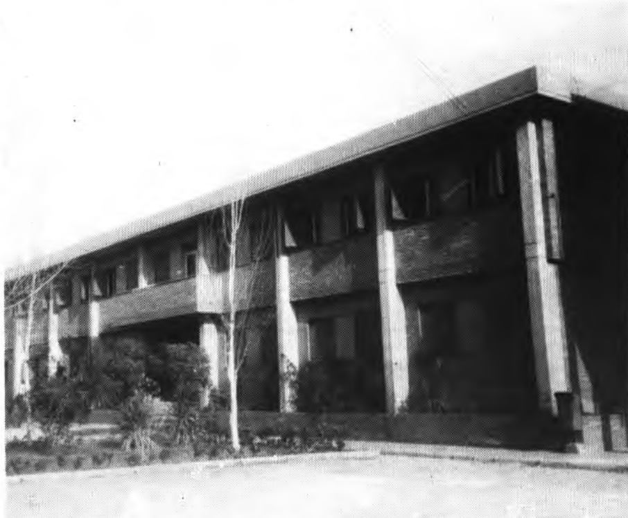
Las obras de las tres nuevas salas ya han comenzado.
