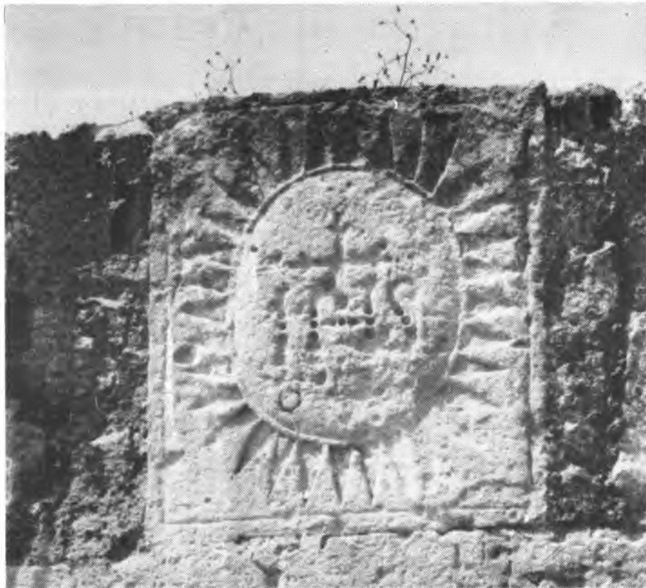
Escut existent sobre el portal de la Torre del molí
