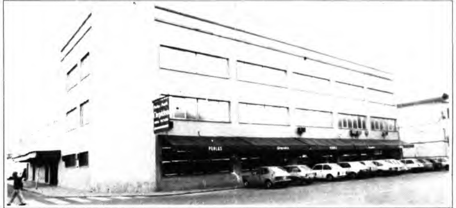
Perlas Orquídea, S.A. pretende ubicar la nueva factoría en las inmediaciones de la carretera Palma-Artà
