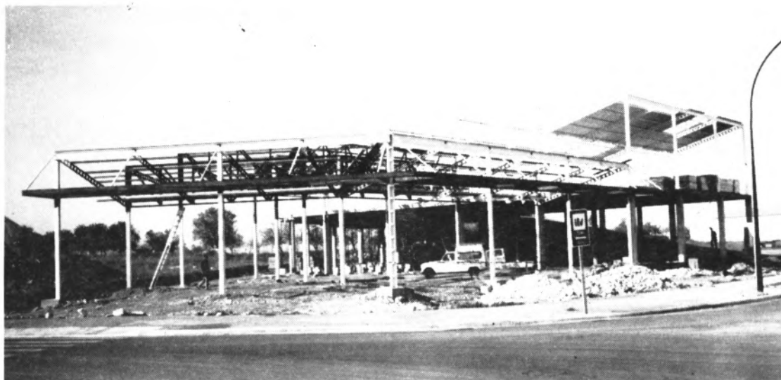
Nave en construcció de Fiat en el Polígono Industrial de Manacor
