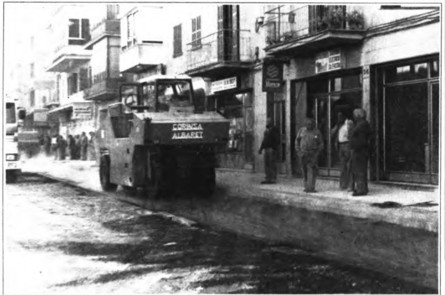
L'asfaltat, una de les darreres fases de l'obra
