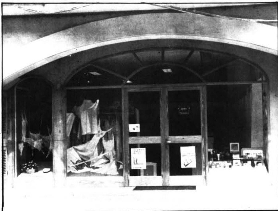
Vista de l'arc del mostrador de la nova tenda Blonda
