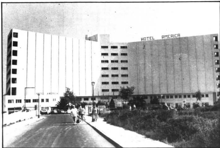
Esta calle está en obras
