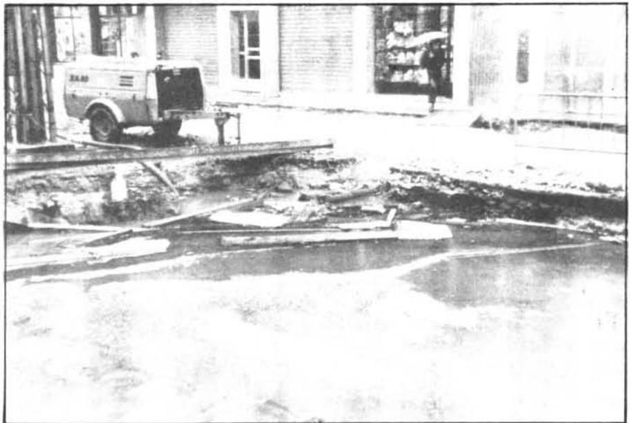
El torrent, allà a on es fa l'obra, es va omplir d'aigua
