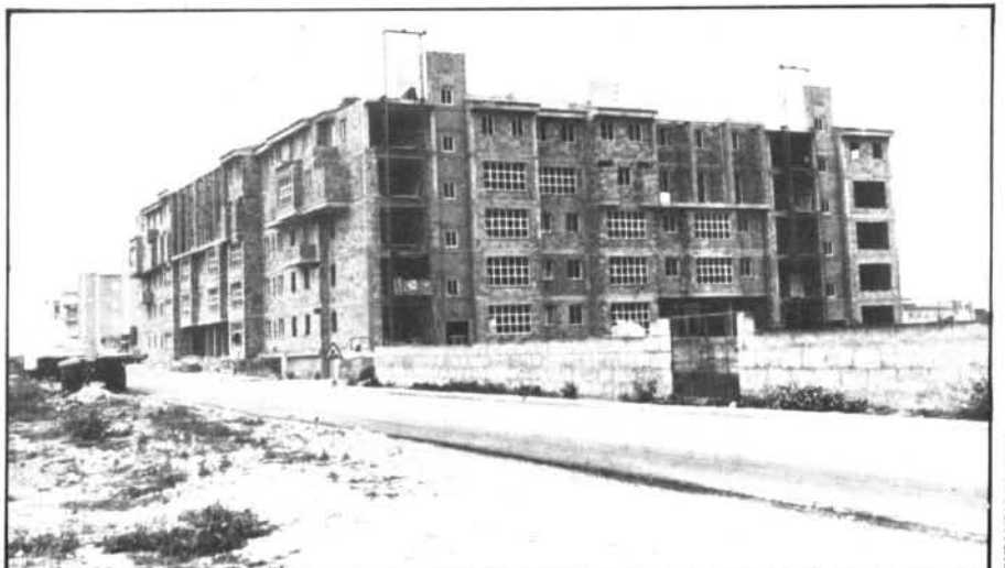
Estado actual de las viviendas de la Ronda del Puerto
