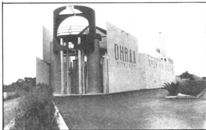
Els cartells indicadors situats a fora vila seran demolits
