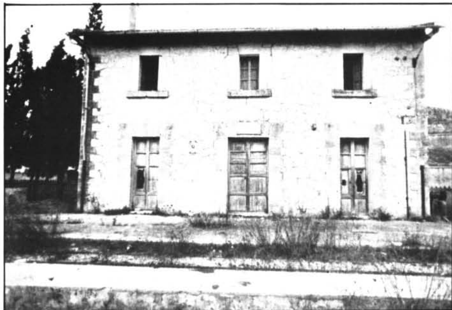
La abandonada estación del tren
