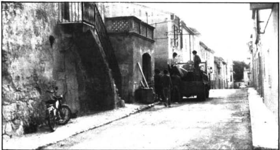
Han començat les obres de neteja.
