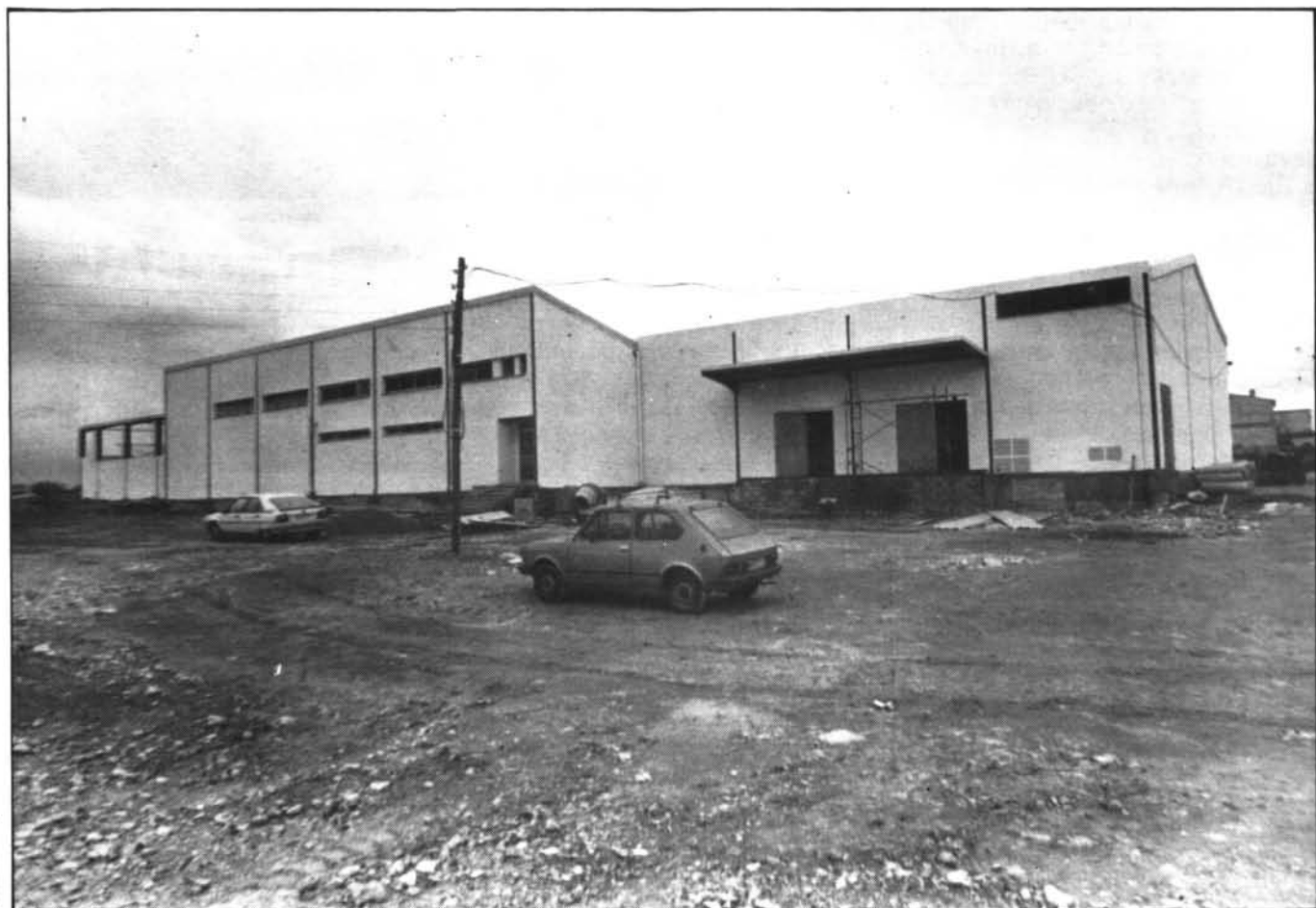
L'edifici del nou escorxador situat a la carretera de Brandís
