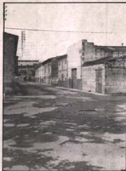
C/ Murillo un de tants en «Mal estat».
