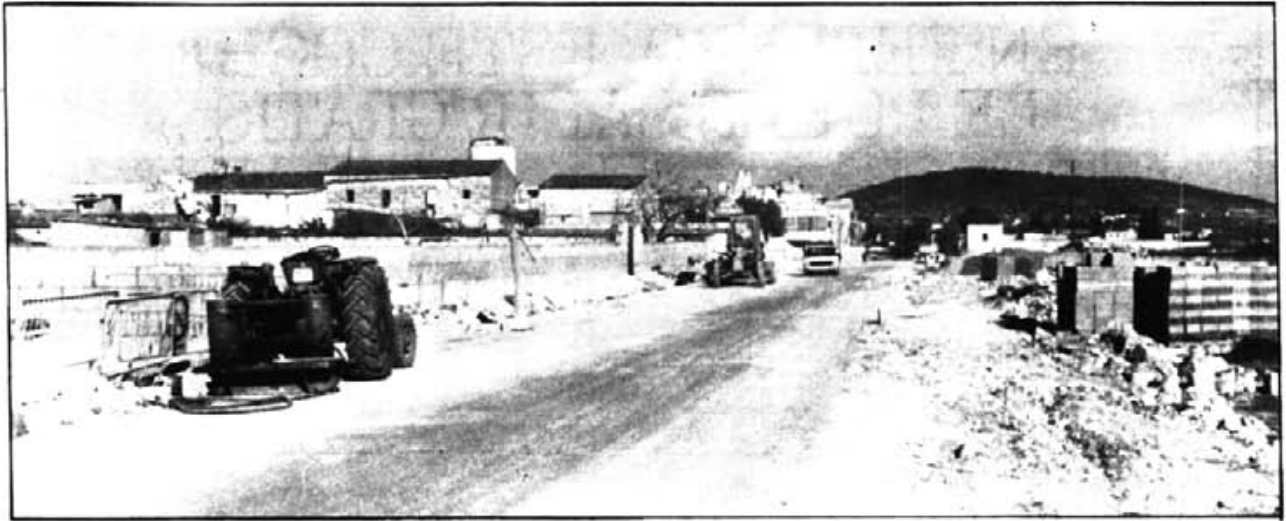
Les obres estan canviant la fesomia de la barriada.
