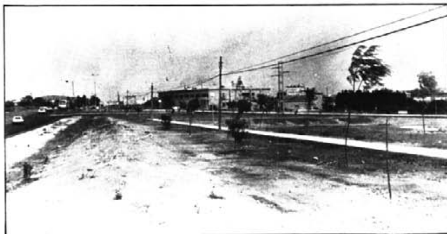
S'instal·larà l'enllumenat públic al Polígon Industrial
