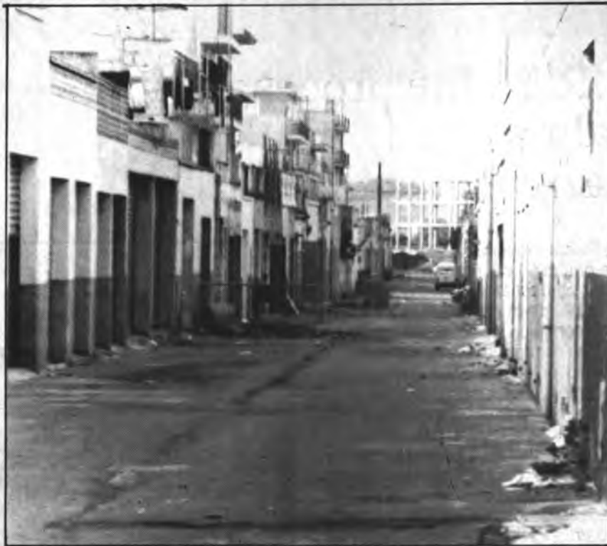
Una panorámica del camino particular afectado
