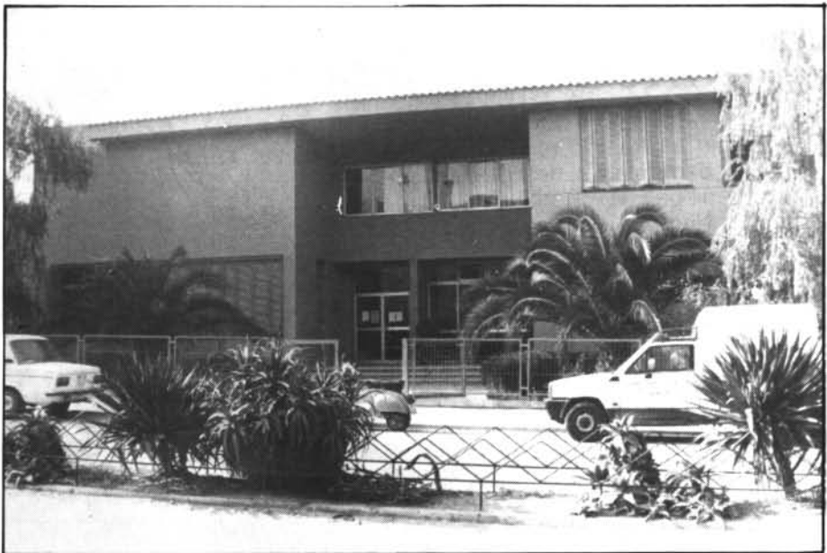
El Simó Ballester té problemes d'obres.
