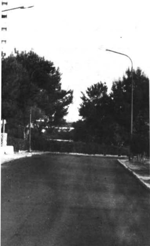
Asfaltado de calles
