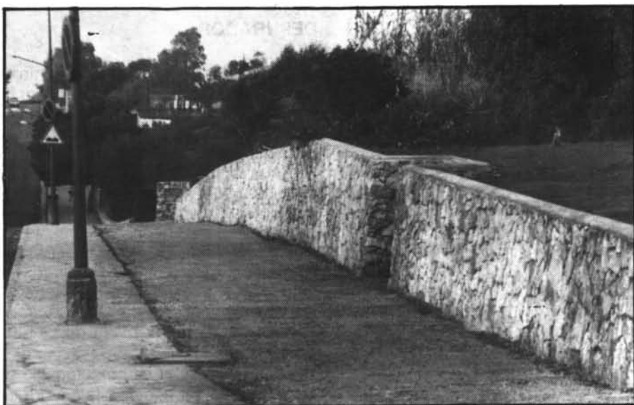
Paseo peatonal Passeig de Manacor
