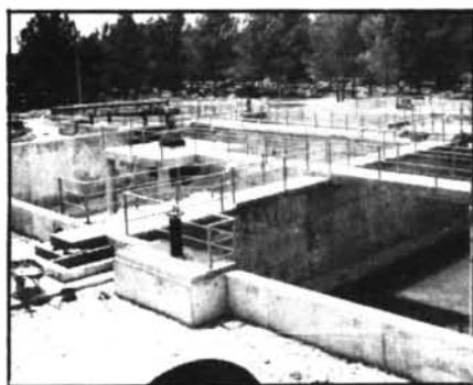
L'estació depuradora, quasi a punt.
