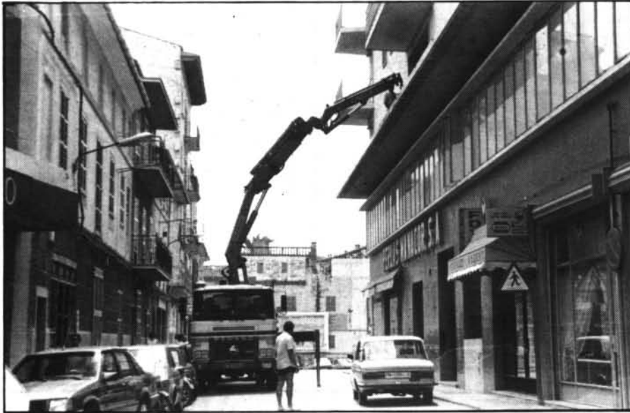
La grua baixant coses de l'edifici de les perles.
