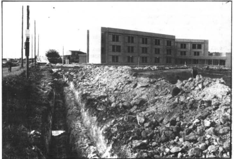
Se dotará al ambulatorio de las acometidas de agua potable, alcantarillado y contra-incendios.
