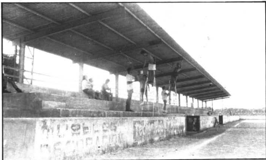
Pintant, voluntàriament, les bigues del Camp de Futbol.
