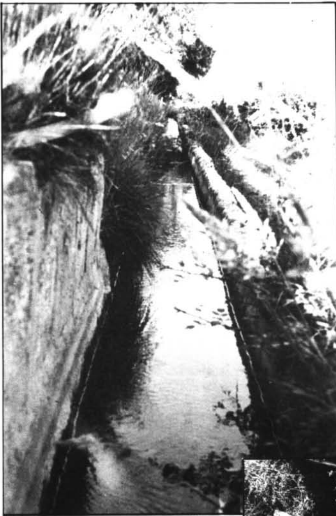
Canalització de s'aigua d'es Molí Paperer -darrerament s'han fet obres per mantenir-lo.
