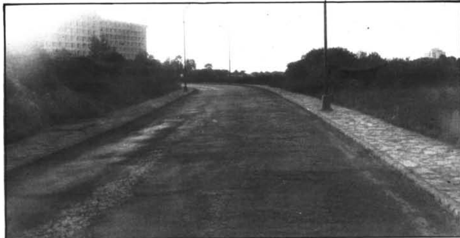
El tramo de carretera que quedó sin asfaltar, podrá completarse, puesto
