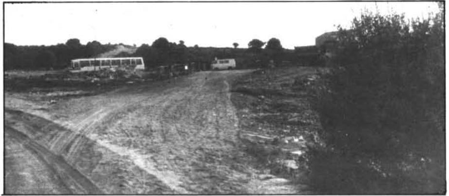
Por esta vía lateral se está desviando el tráfico de forma provisional.
