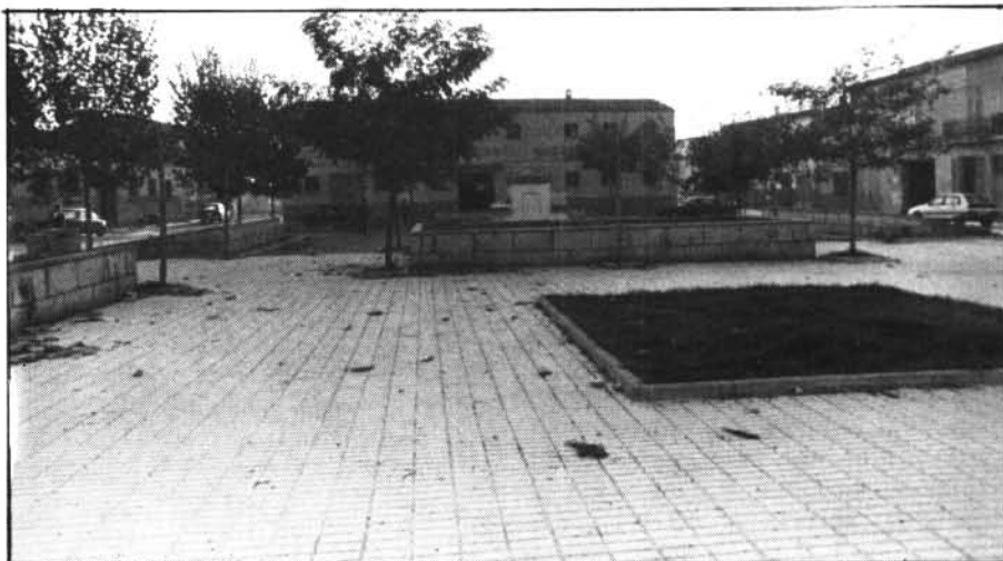
Si l'INEM ho subvenciona, s'acabaran les obres de la plaça Indústria.
