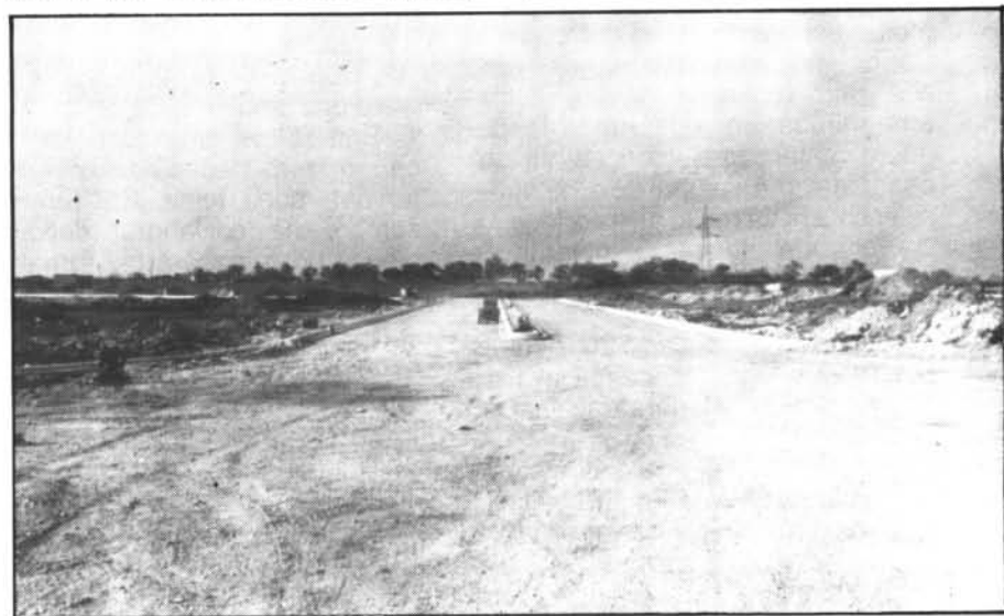
S'està acabant la infraestructura bàsica
