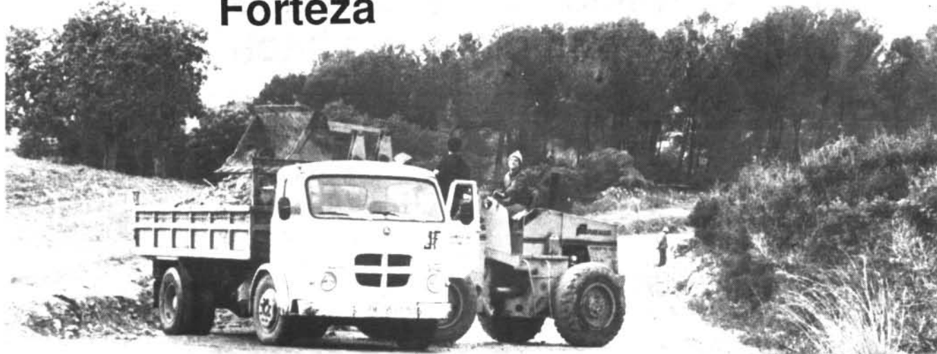
Se han realizado las obras de parcheo
