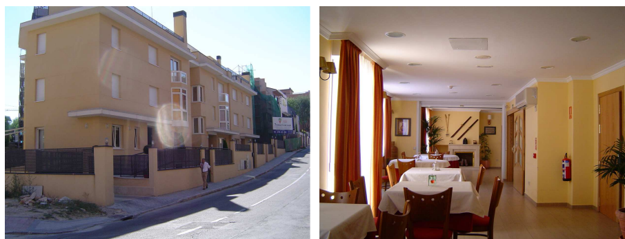
Fig.68.- Vista general del complejo residencial y comedor-salón comunitario
