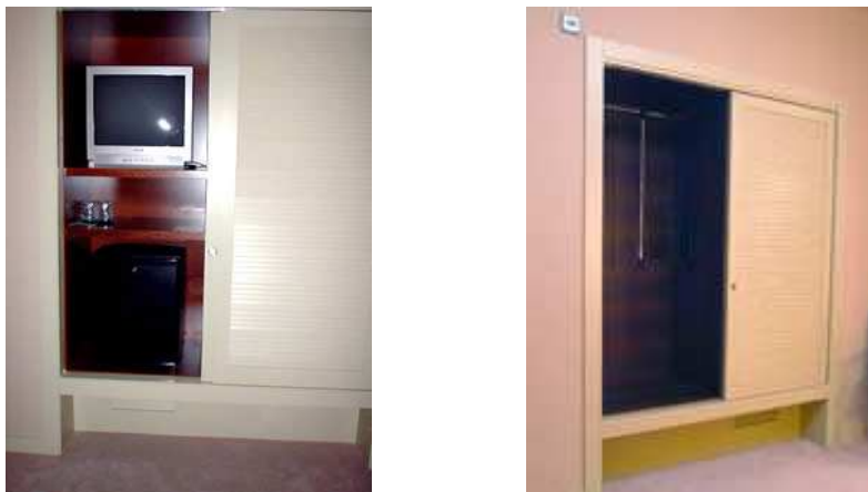
Fig. 62.- Detalles en armarios y mueble bar elevados para una fácil aproximación. ( http://www.hotelcondes.com/ )
