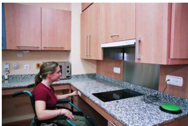
Fig. 73.- Cocina con interruptores para movilizar armarios y encimera con hueco inferior.
