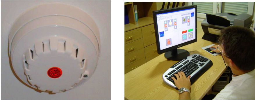
Fig. 71.- Sensor para humos y panel de control del estado de las habitaciones
