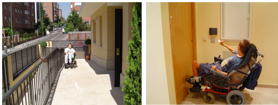
Fig. 70.- Rampa exterior de acceso a los pisos y sistema de apertura-puertas por llavín-sensor
