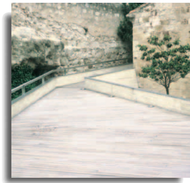
Fig. 32. Rampa de acceso al Museo Provincial de Zamora.
