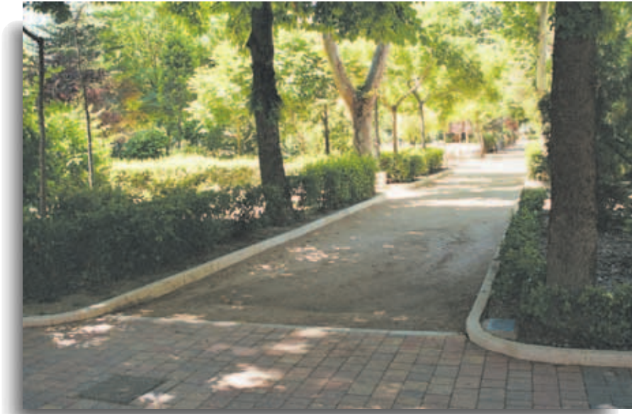
Nótese la cuidada transición de pavimentos y la junta que los delimita. Parque de San Julián. Cuenca.
