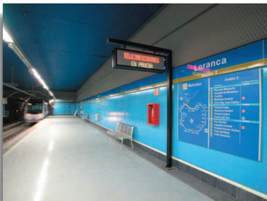
Señalización en pantalla electrónica. Metro de Madrid.
