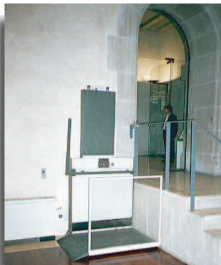
Fig. 14 y 15. Salvaescaleras y plataformas que no interfieren con el recorrido peatonal. Cuando están inactivos ofrecen mejores condiciones de seguridad. Una colocación como la que aparece en la fig. 16 reduce el ancho útil de la escalera y obstaculiza la circulación peatonal próxima al edificio.
