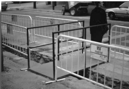
Solución de paso sobre zanja en un paso de peatones.
