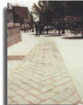
Encaminamientos en la Plaza de Lavapiés. Madrid.
