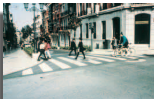
Fig. 10. Calle con flujos al mismo nivel separados por elementos lineales que desaparecen en las zonas de cruce.
