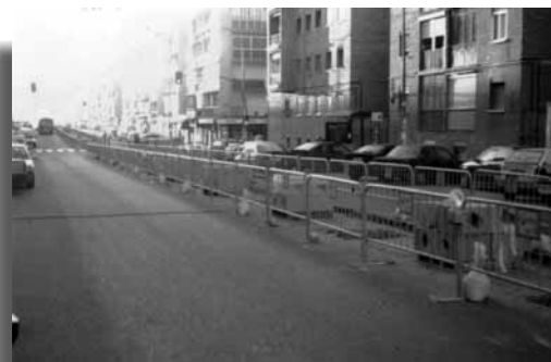
Zona de trabajos protegida con vallas móviles y balizas luminosas.
