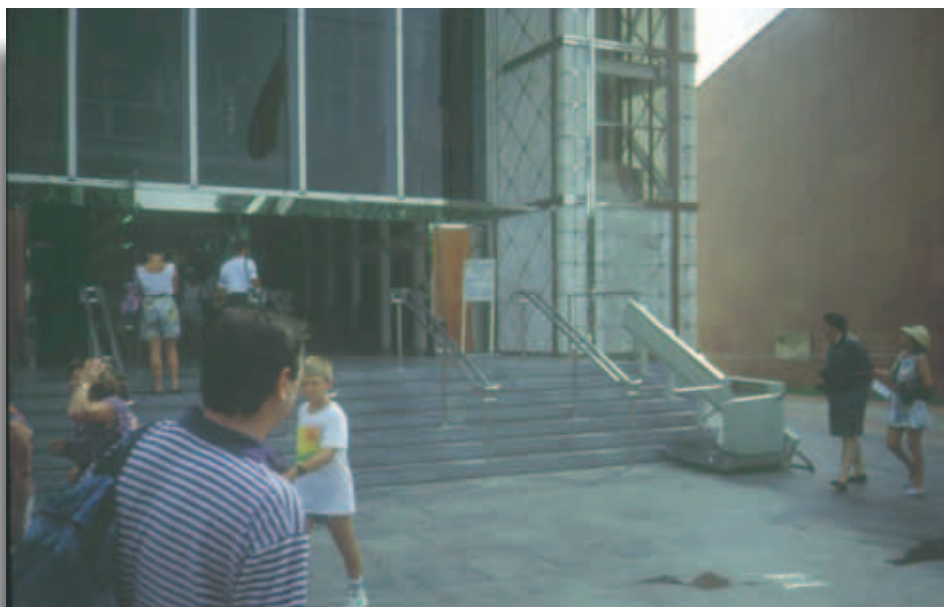
Fig. 16. El edificio dispone de dos ascensores simétricos colocados a ambos extremos de la escalera de acceso. Conectan todas las plantas del edificio pero no llegan al nivel del espacio exterior lo que obliga a colocar un salvaescaleras y numerosos pasamanos para acceder a la planta baja.
