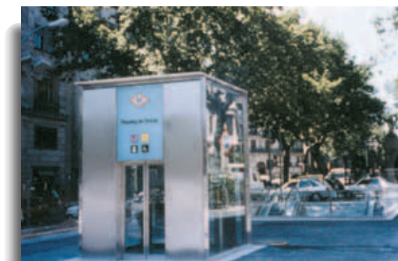
Ascensor del metro de Barcelona.
