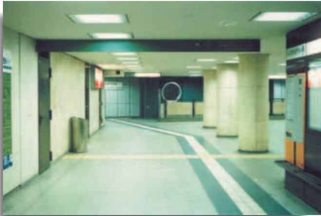
Encaminamientos en una estación del metro de Hamburgo.
