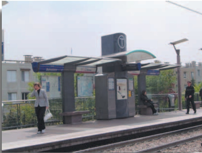
Tranvía de París. Marquesina dotada con toda la señalización informativa necesaria.
