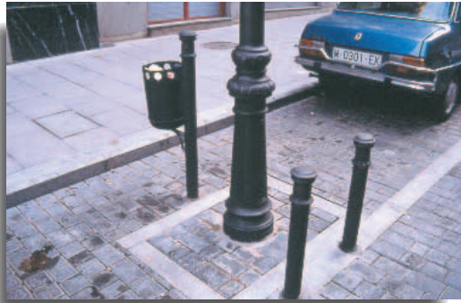
Acera estrecha. Instalación del mobiliario en la banda de estacionamiento.
