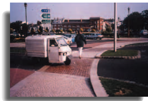
Solución en rotonda elevada. El contraste de materiales es adecuado.
