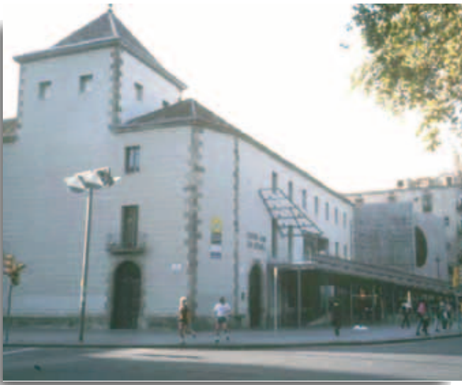
Fig. 42 y 43. Centro Cultural Santa Mónica. Barcelona. Proyecto de rehabilitación de Piñón y Viaplana (1985-1989). La reconversión de un convento en centro de arte genera nuevas necesidades de acceso, resueltas con una rampa hasta la entrada principal que se convierte en un recorrido con perspectivas inéditas sobre el tramo final de las Ramblas y el monumento a Colón.
