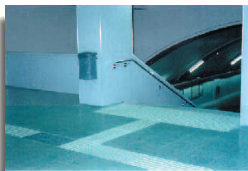
Encaminamientos en el metro de Barcelona.
