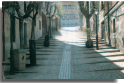
Fig. 14. Ejemplo de rehabilitación de calle en pendiente.
