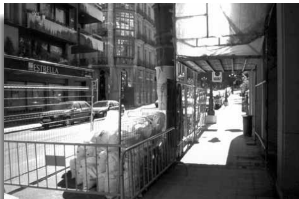
La zona de acopios y escombros se realiza en la calzada, dejando todo el ancho libre de la acera.
