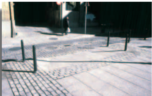
Fig. 13. Ejemplo de paso de peatones estándar resuelto con el lenguaje utilizado en la intervención histórica.
