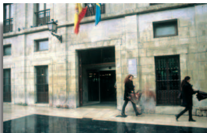
Fig. 18. Ejemplo de eliminación de escalón de entrada, en la zona exterior pública.
