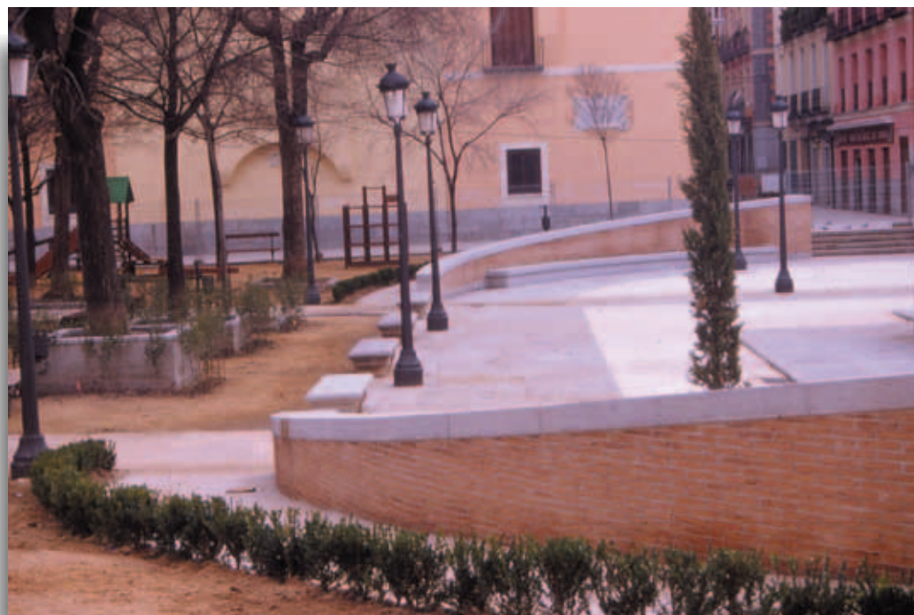
Rehabilitación de la Plaza Dos de Mayo. Madrid. Rampa de acceso a la plaza.
