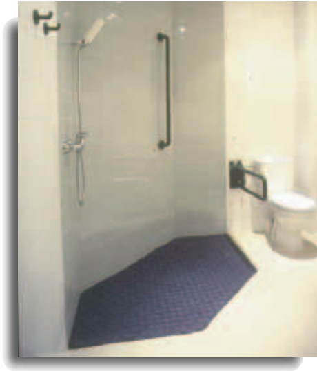
Fig. 9 y 10. Es sencillo conseguir pavimentos antideslizantes para baños pero la dificultad estriba en la limpieza. Pavimentos muy rugosos acumulan partículas que resultan difíciles de eliminar mientras que soluciones de doble pavimento retienen la humedad y favorecen la proliferación de microorganismos.
