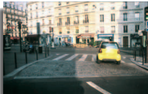
Fig. 11. Ejemplo de cruce con calzada sobreelevada.
