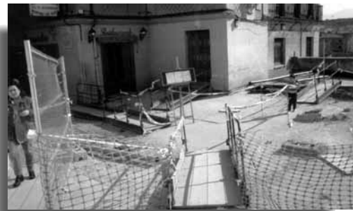
Ejemplo de itinerario practicable dentro de la propia obra merced a pasarelas y cintas de balizamiento que las unen. Según las necesidades de la obra, los recorridos se van cambiando.
