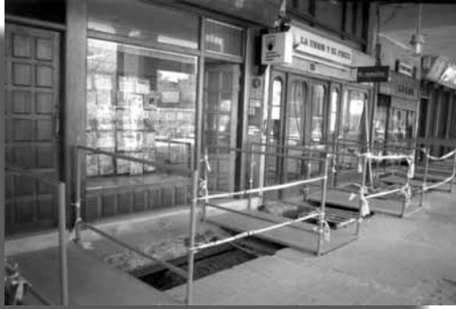
Vista de las pasarelas de peatones accediendo a comercios y portales.
