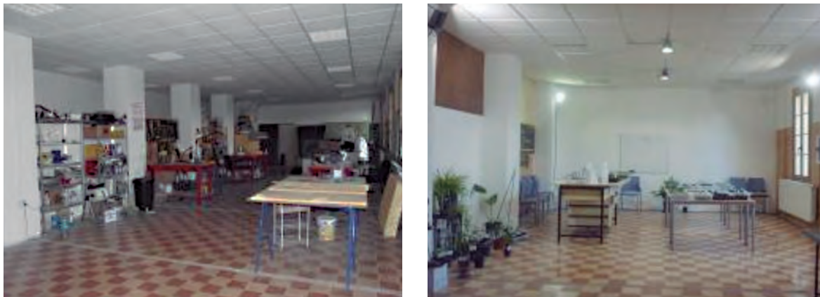
Imagen 13. Espacio de talleres antes de la intervención y tras la reforma
