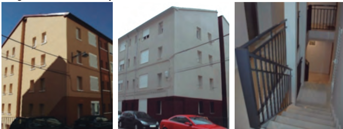
Imagen 20. Edificios n.º 6 y n.º 10 de la calle Luis Buñuel
