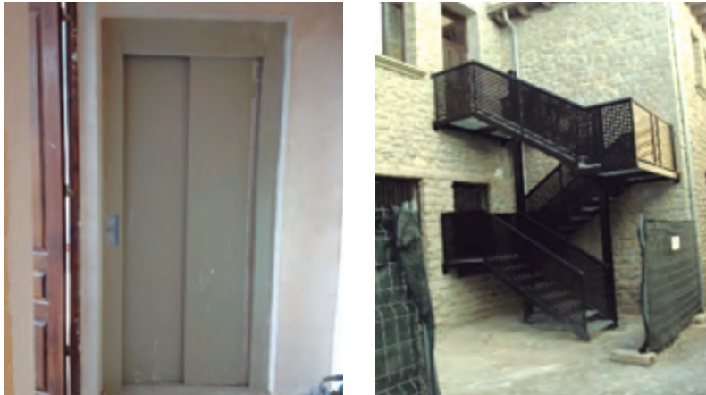
Imagen 11. Ascensor y escaleras de emergencia en el edificio destinado a centro de innovación y formación educativa
