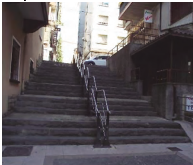
Imagen 3. Tramo de escaleras entre calle Ordesa y calle Coli Escalona
