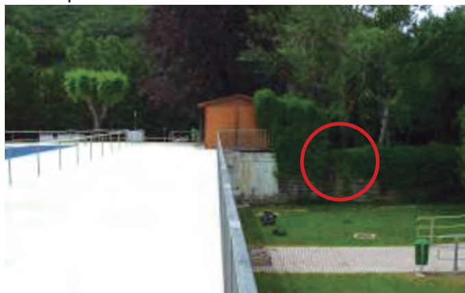
Imagen 6. Fotografía de la parte de la piscina en la que se abrió un acceso
