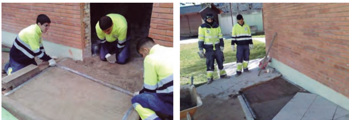
Imagen 2. Realización de una rampa de acceso en la Plaza Constitución
