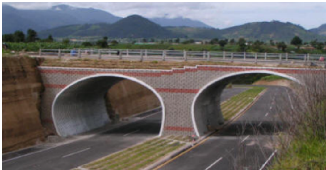
Imagen 21. Periférico del Municipio de Salcajá, Quetzaltenango
