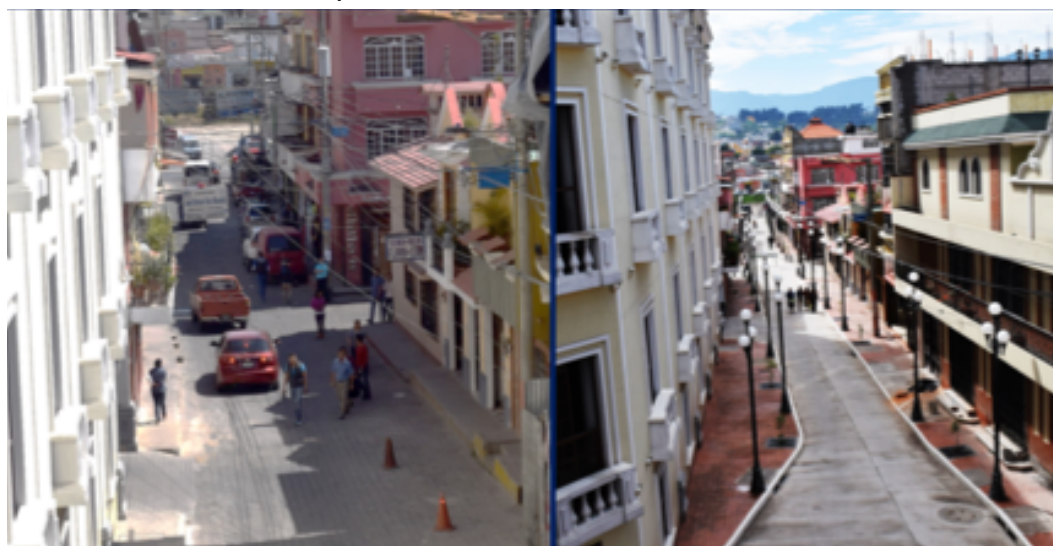
Imagen 22. Antes y después Primera Calle Zona 1, Salcajá
