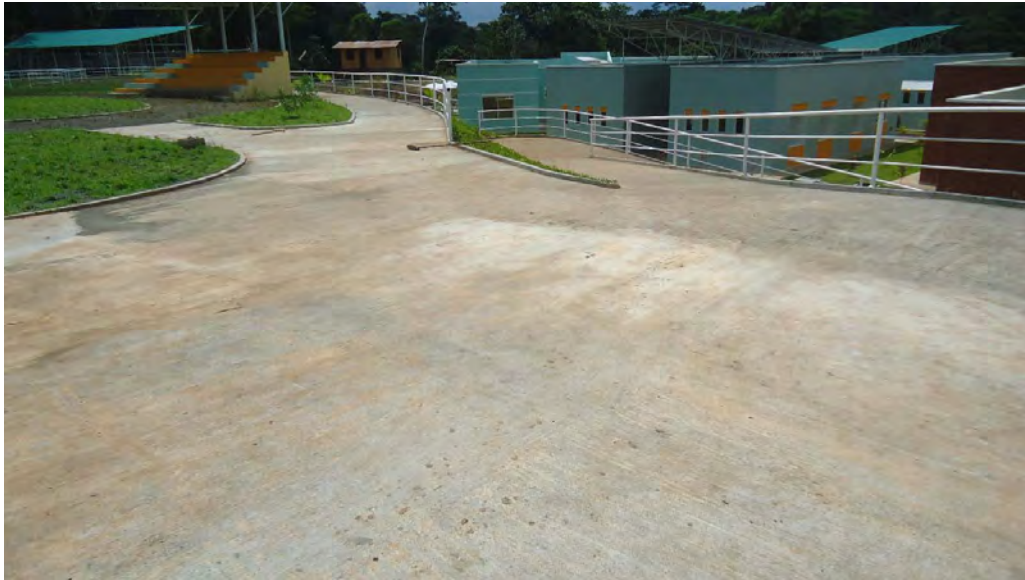
Accesos de rampas en los niveles de diferentes alturas en la escuela de niños especiales Manuela Cañizares
