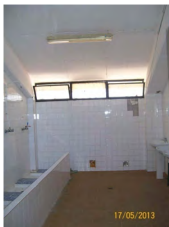
Estado sin reformar
