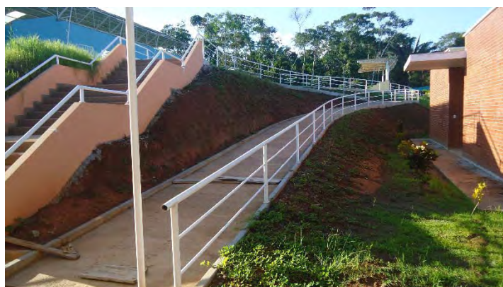
Accesos de rampas de la escuela de niños especiales Manuela Cañizares
