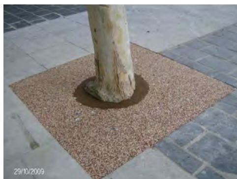
Ejecución de alcorques mediante el sistema BASEFILT para evitar desniveles.
