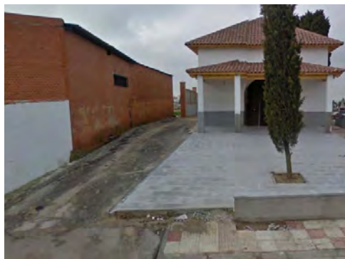
Acceso a cementerio. Estado previo.
