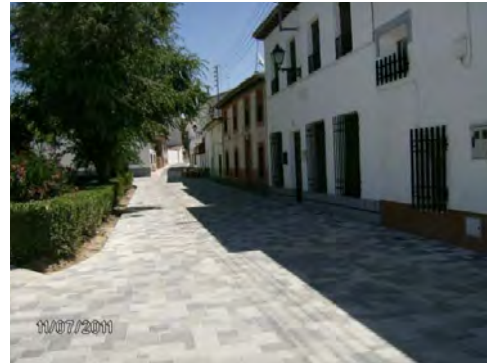
Calle Cubas. Estado reformado accesible.
