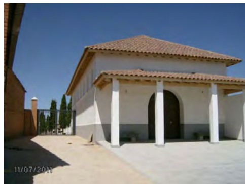
Acceso a cementerio. Estado reformado accesible.
