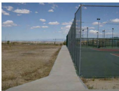
Itinerarios accesibles en el interior del recinto (Obras realizadas en 2010).
