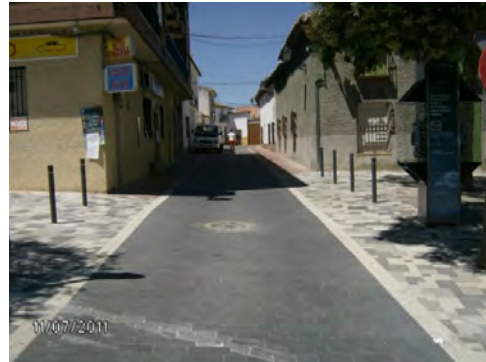
Pza. Eras (C/ Imperial). Estado reformado accesible.
