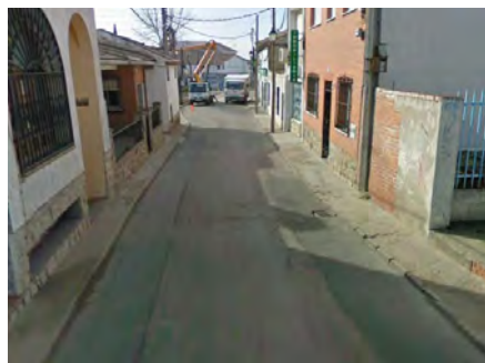
C/ Serranillos. Estado previa remodelación.
