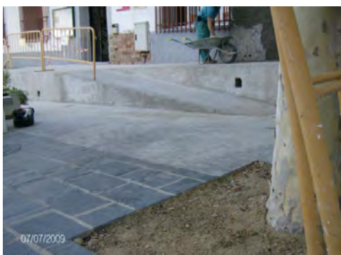
Ejecución de alcorques mediante el sistema BASEFILT para evitar desniveles.
