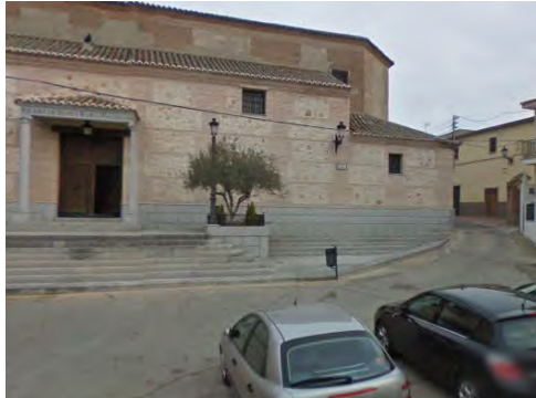
Plaza de la Iglesia. Estado previo.
