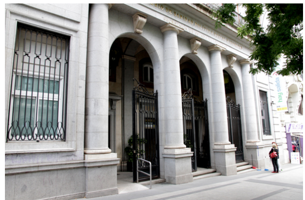
Figura 33: Acceso a oficina administrativa
