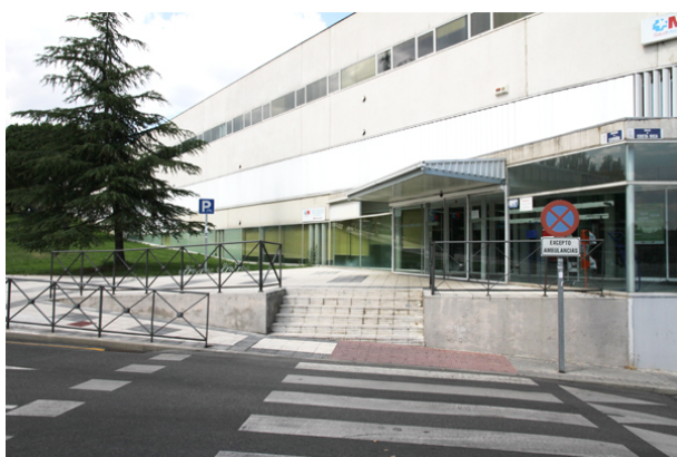
Figura 30: Acceso a hospital por rampa e itinerario
