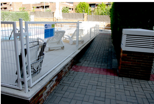
Figura 28: Acceso a piscina por rampa
