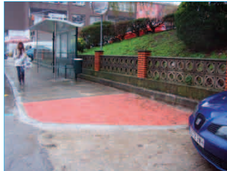
Obras de accesibilidad en la calzada (antes y después).
